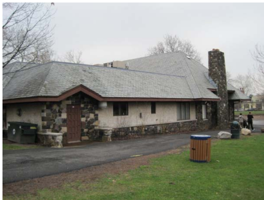
Left Side Façade
