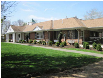
Left Side Façade
