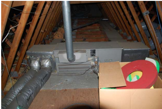
B wing Lux-Aire furnace
