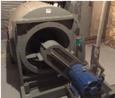
Air Handling Unit Fan Section
