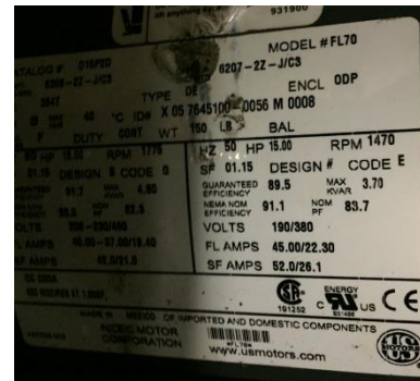
AHU Supply Fan Nameplate
