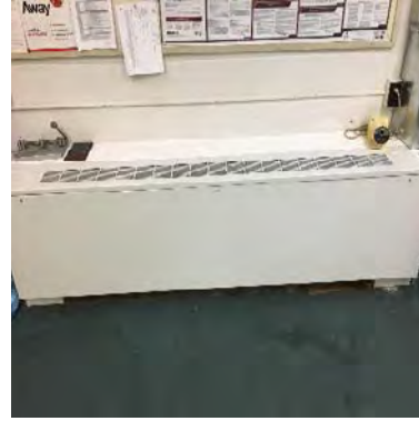
Fan Coil Units
