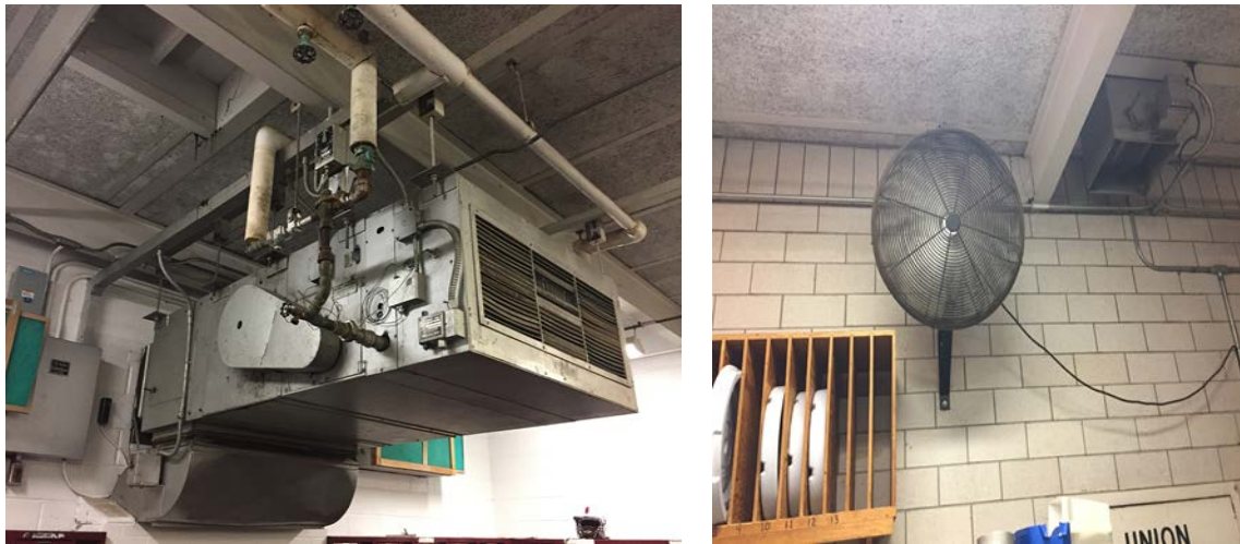
1AHU and Ventilation Fan
