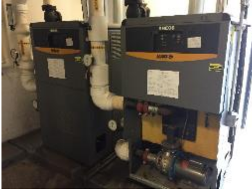
Laars Rheos boilers
