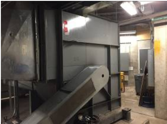
AHU 5 – Return Fan
