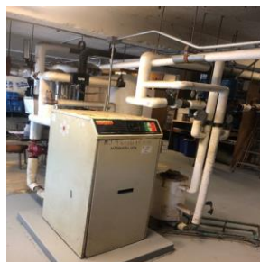
AO Smith Condensing Boiler
