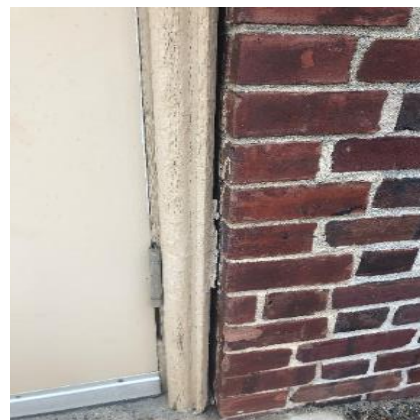
Worn out door frames
