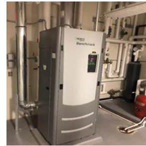
Aerco Condensing Boiler
