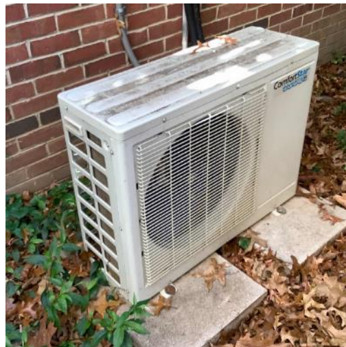
Ductless Mini Split System Air Conditioner
