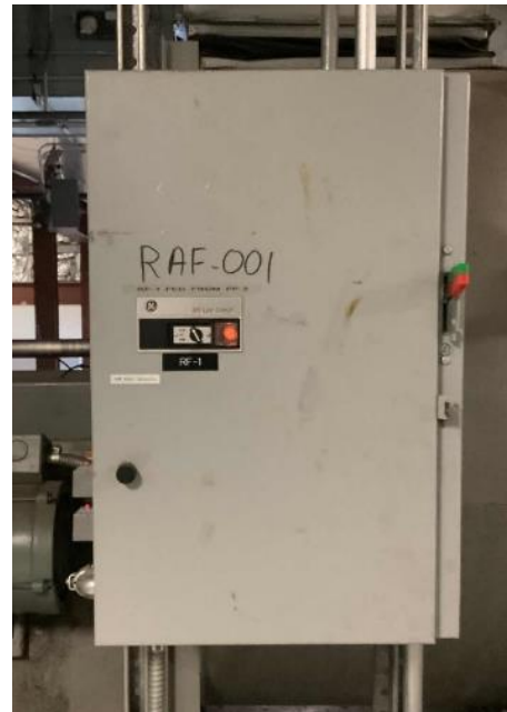
AHU-1 Return Fan Control
