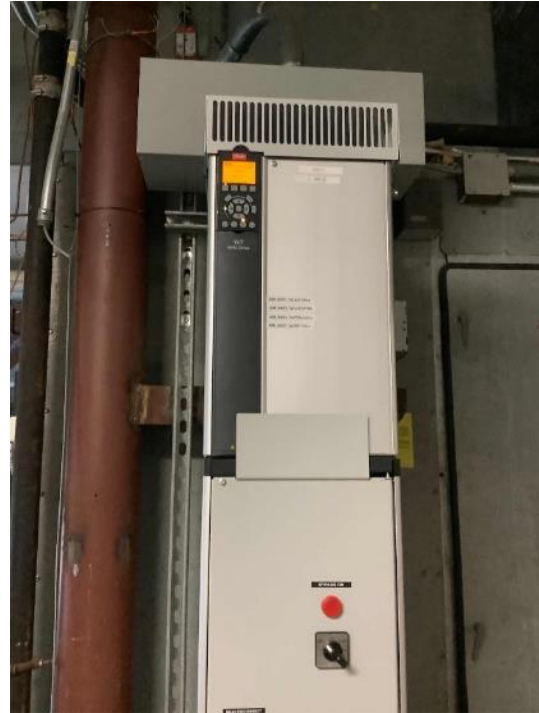
Supply Fan VFD Control
