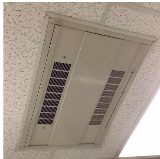
Rest Room Fan Coil Unit
