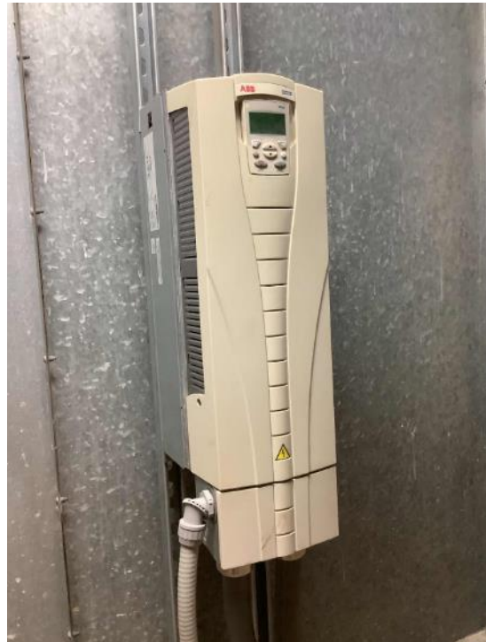
AHU-001 VFD
