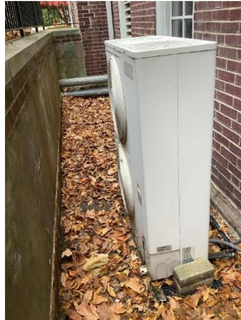
Bliss Hall Ductless Mini Split System AC
