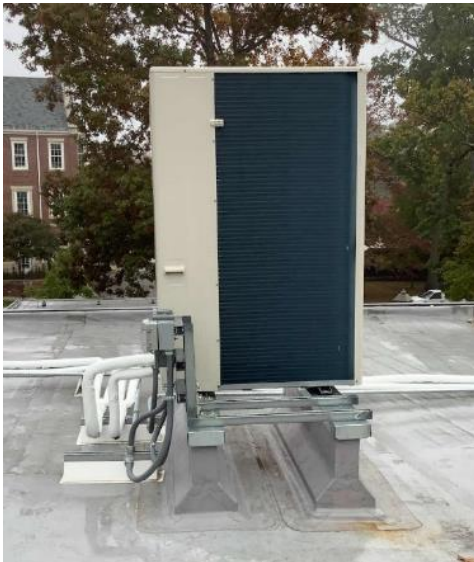
Ductless Mini Split System Heat Pump
