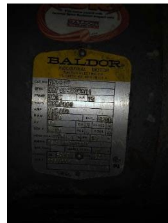
Ventilation Fan Nameplate
